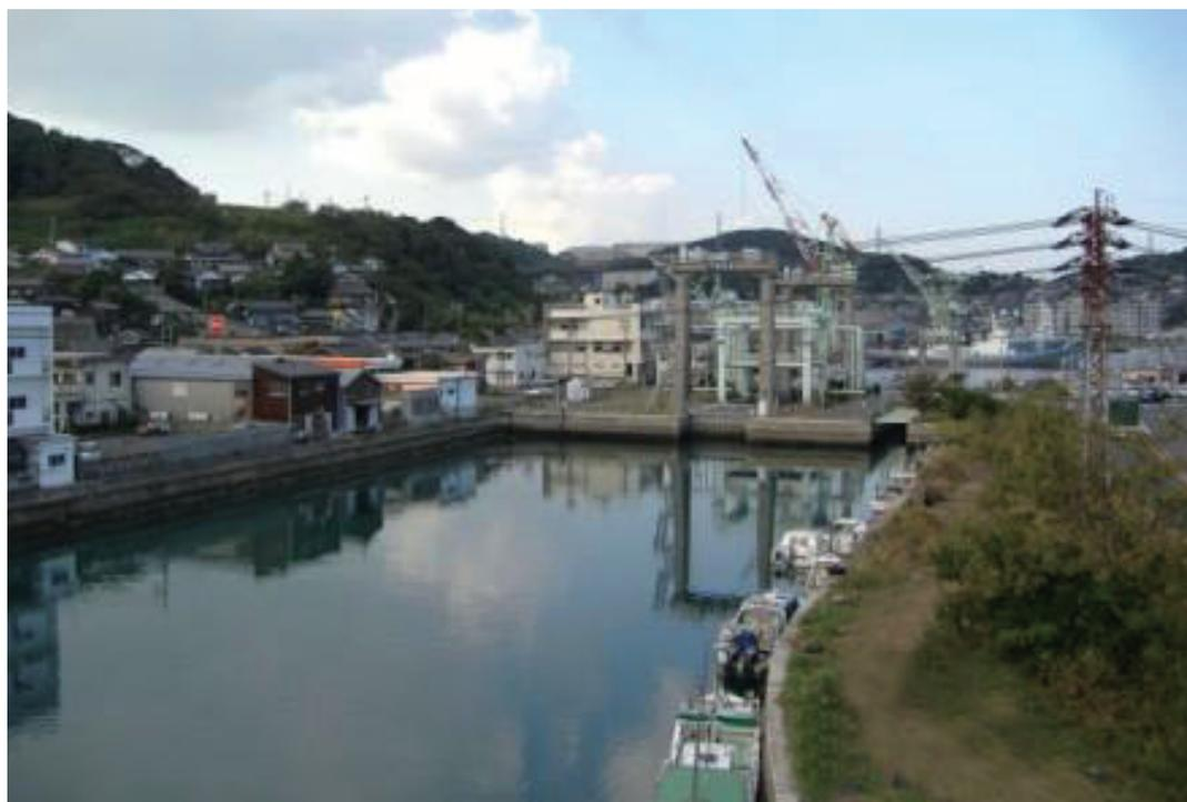
下関漁港の閘門こうもんは、日本海と瀬戸内海の干満差によって生じる激しい潮流を抑制し、漁港の安全性を確保するために戦前に建設された構造物。戦後の下関漁港の発展に多大な貢献をしており、昭和41年には28万5千トンの水揚量日本一に輝いた。閘門は今なお現役稼働中で船舶が航行しており、このような構造物は全国的にも珍しい。閘門の通過方法は規模の大小はあるがパナマ運河と同じである。
