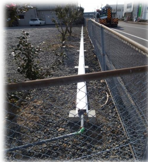
公道水素配管
