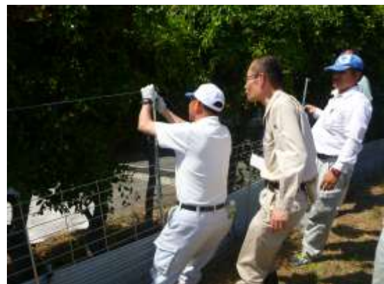
防護柵の設置実習（農大）
