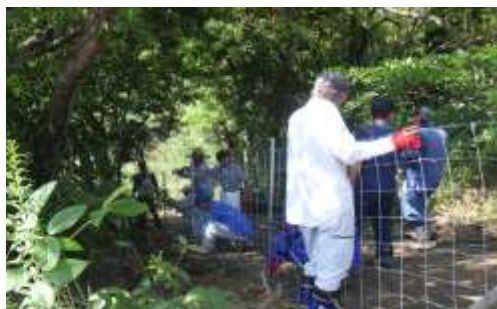
住民自らが侵入防止柵を設置
