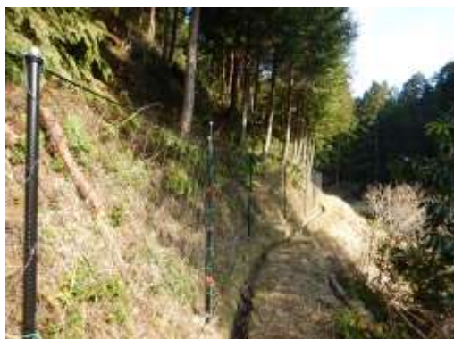
R元 森林環境保全整備事業 [鳥獣害防止施設等整備] シカ防護柵設置事業地 (美祢市)
