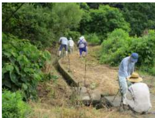
電気柵の設置作業 （長門市仙崎 青海集落協定）
