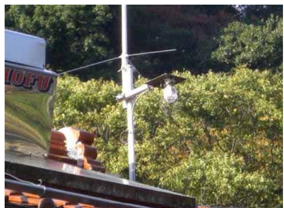
民家に設置した固定基地局(仁保)
