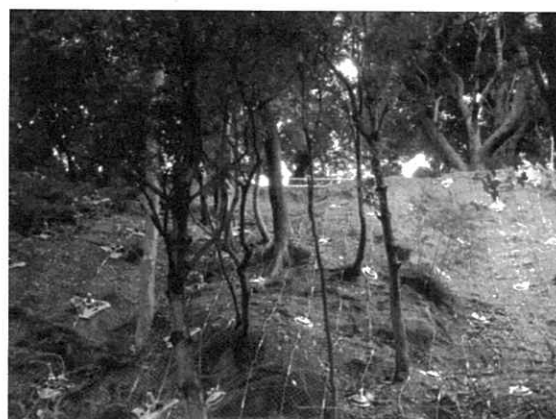
山腹工による災害復旧
