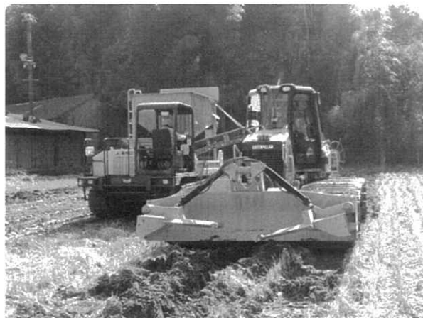
地下水位制御システムの工事状況
