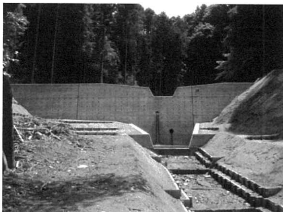
治山ダムの整備
