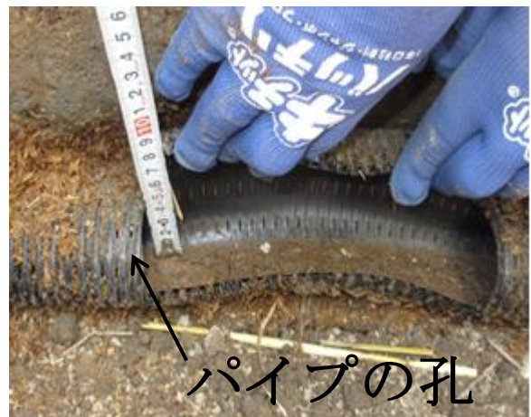
図6 パイプ内状況 (洗浄前①)
