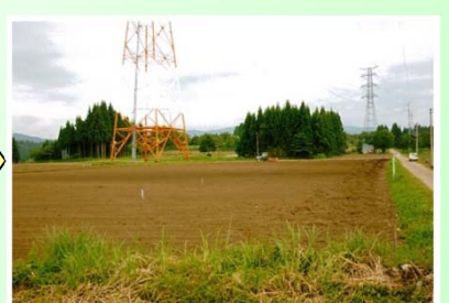
再生作業完了
