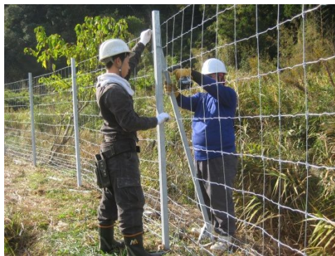
【鹿用防護柵設置】
