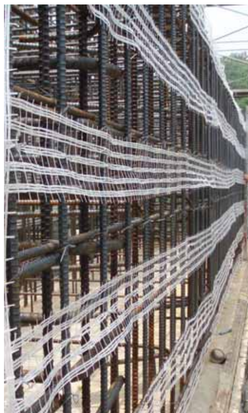
図 3.2.5 ガラス繊維設置状況
