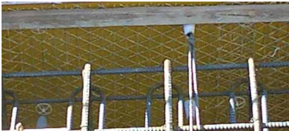
図 3.2.3 アラミド繊維設置状況
