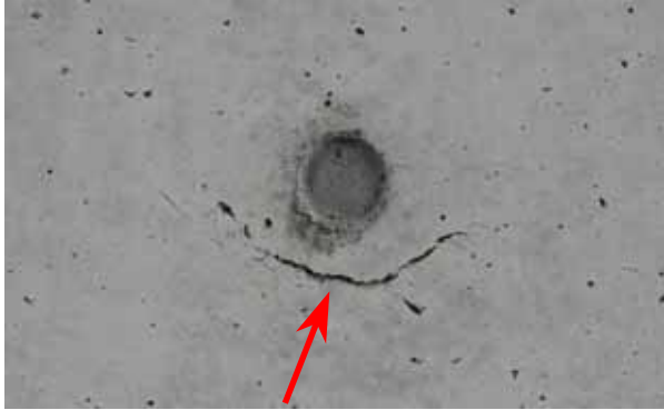
【セパレータのコーン跡下方】
