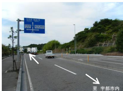
北迫交差点付近の開通後の状況
