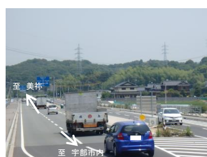
善和交差点付近の開通後の状況
