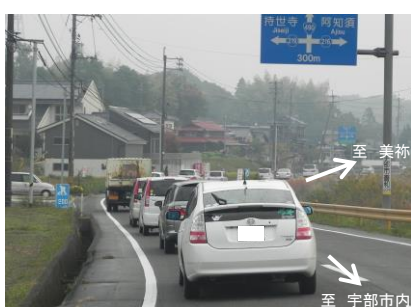
善和交差点付近の整備前の状況
