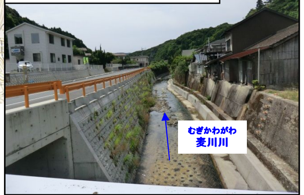
事業区間 (中麦川橋付近)
