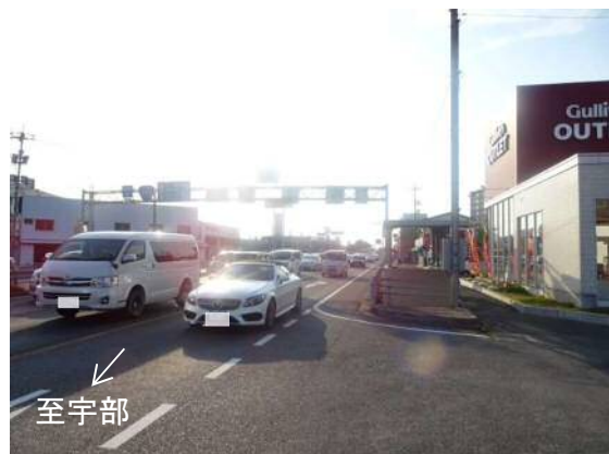
整備後 (国道190号)
