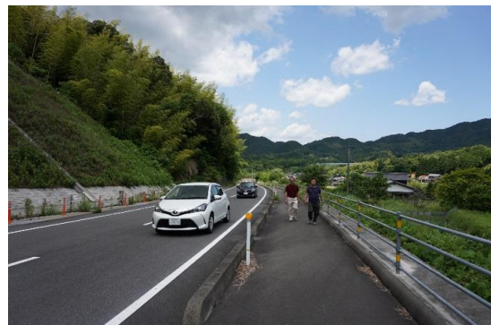
② 部分供用区間の状況
