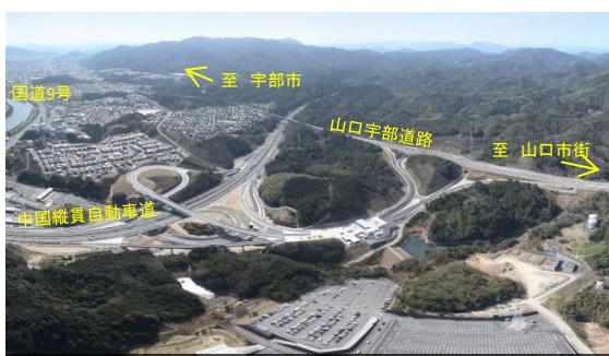
整備後の状況 (小郡JCT)
