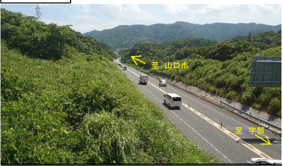
整備後の状況 (本線部)
