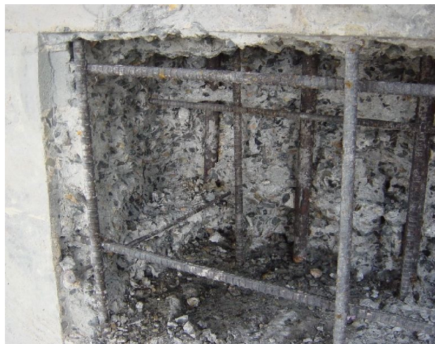
図 2.38 A1 橋台部縦壁鉄筋の状態
