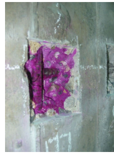
写真5. 中性化深さ測定結果状況 B-C点付近写真
