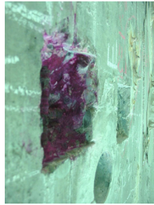
写真5. 中性化深さ測定結果状況 F-G-H点付近写真
