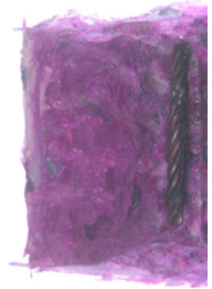
写真4. 中性化深さ測定結果状況 H-A-B点付近写真
