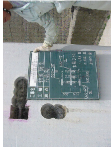
写真3. 鉄筋腐食状況調査結果状況
