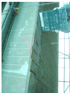
写真1. 調査位置状況 付近に剥離、鉄筋露出、浮き及び、ひびわれ
