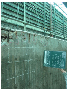
写真1. 調査位置状況 付近に剥離、鉄筋露出
