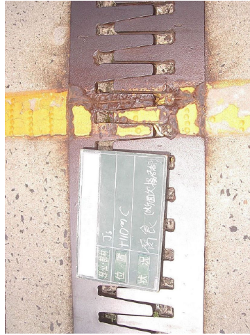
写真3. 中央部伸縮装置
