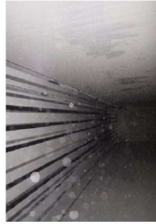
⑤PC鋼材、内面状況
