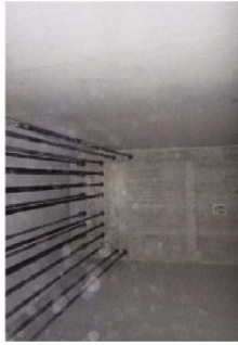
①P2部隔壁状況
