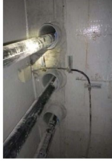
②PC貫通孔状況
