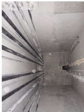
⑫隔壁2 壁面状況
