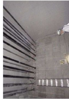
⑦隔壁1 壁面状況
