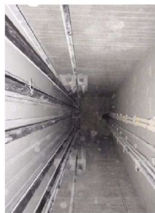
⑪ 内空状況
