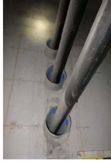
③PC貫通孔状況
