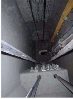
②PC貫通孔状況
