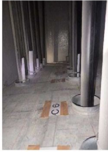
②PC貫通孔状況
