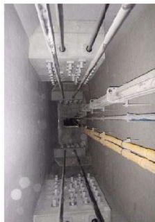
⑥隔壁状況
