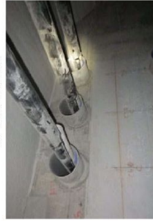
④PC貫通孔、壁面状況
