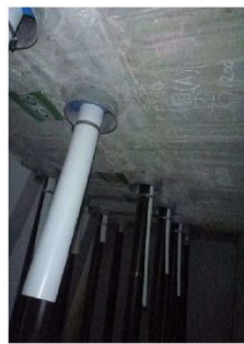
⑬PC貫通孔状況
