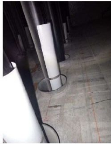
③PC貫通孔状況
