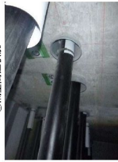
⑨PC貫通孔状況
