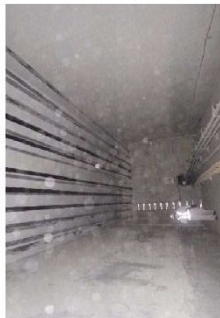
⑥隔壁1 状況
