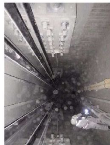
⑬ 内空状況
