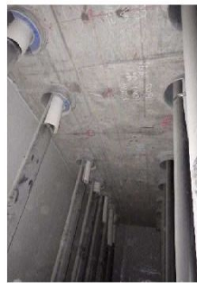
⑨隔壁1 PC貫通孔状況
