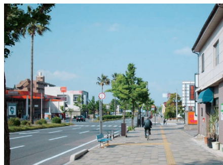
電線地中化後
