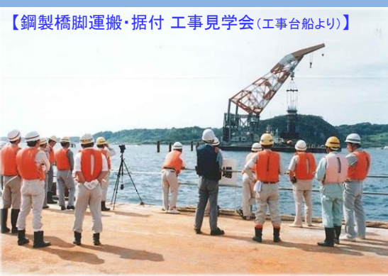
下部工施工(平成8年9月)
