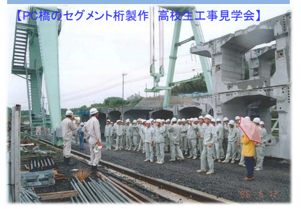
上部工施工(平成8年6月)
