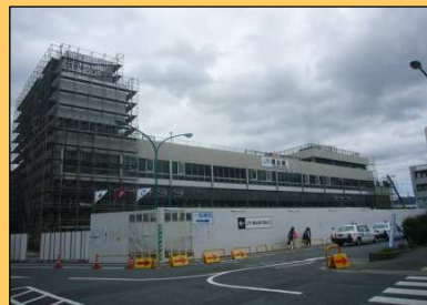
現駅ビル解体状況 (H30年度 新駅ビル開館予定)
