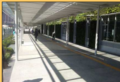
自由通路・橋上駅舎 (H27.10.3 供用開始)
