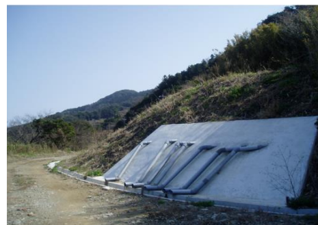
横ボーリング工
