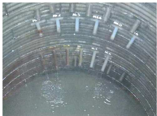
写真 5.8 集水井工（集水ボーリング工） の対策完了状況
