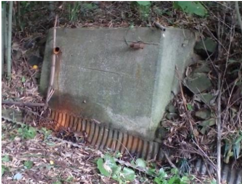
写真 5.5 横ボーリング工の劣化損傷状況
