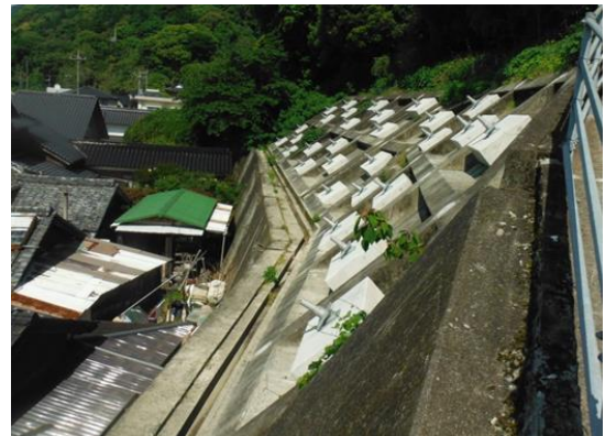
写真 5.11 対策施工完了
