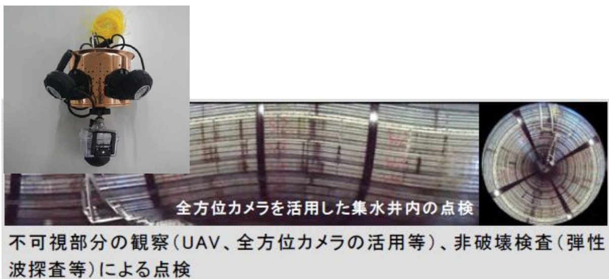
図 6.10 全方位カメラを活用した集水井内の点検写真
