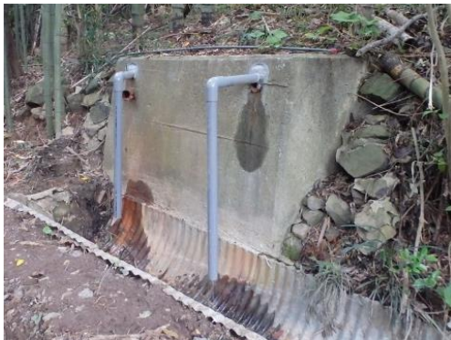
写真 5.7 横ボーリング工の対策完了状況
