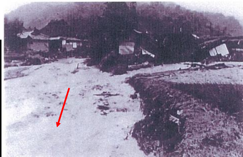
昭和47年7月11日洪水:仁保川洪水状況
