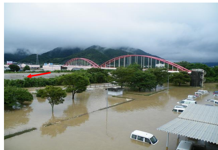
平成21年7月21日洪水:榎野川被害状況
