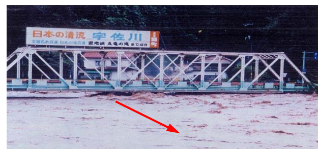
平成11年9月：台風18号_岩国市錦町出合橋付近
