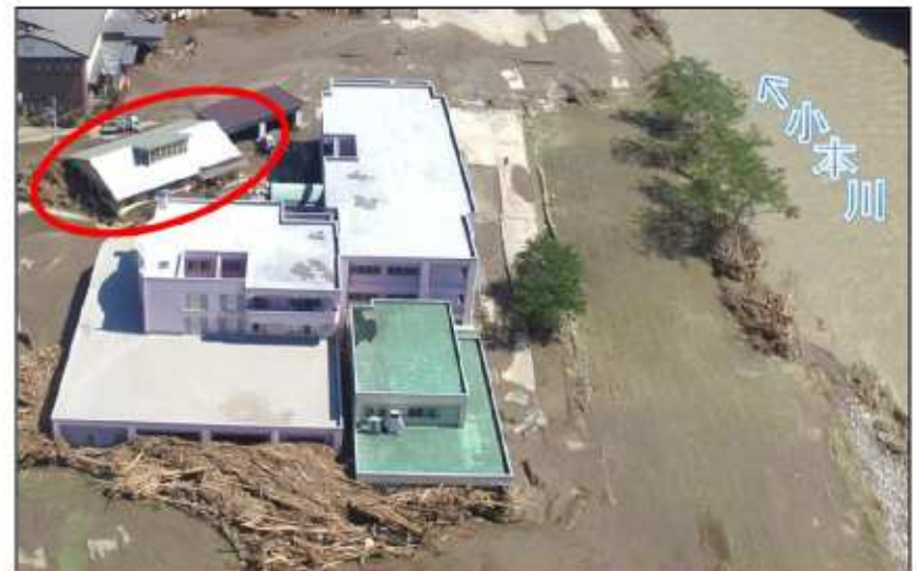
平成28年台風10号により、岩手県の要配慮者利用施設では利用者9名の全員が死亡。
