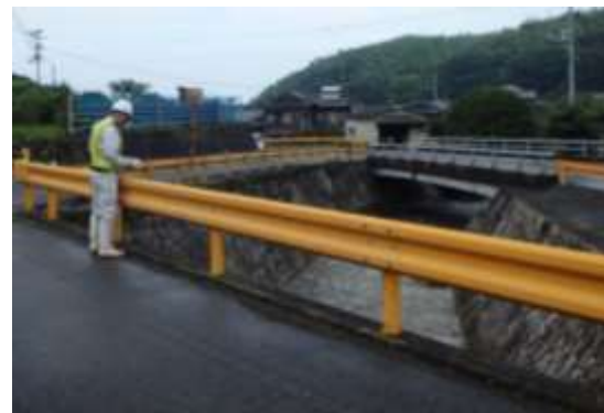
<河川巡視状況>
