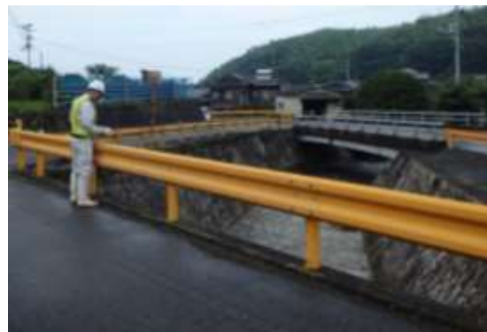
<河川巡視状況>
