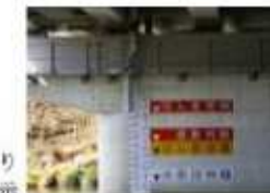
水位計による観測値をテレメータで収集し提供
