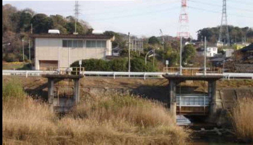
有帆川排水機場
