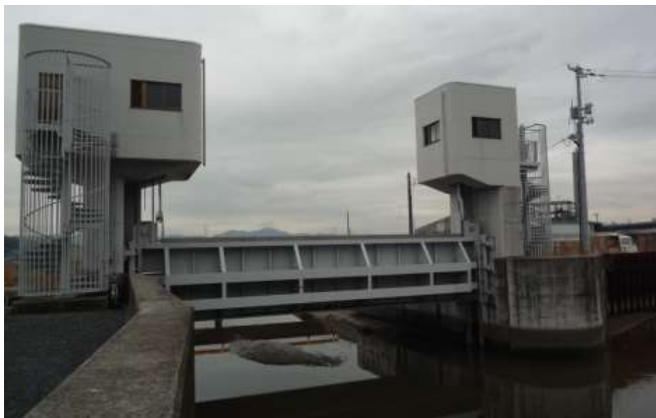
灸川排水機場
