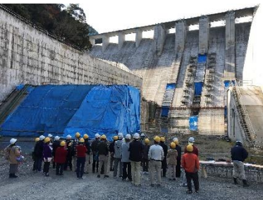
現場見学会状況
