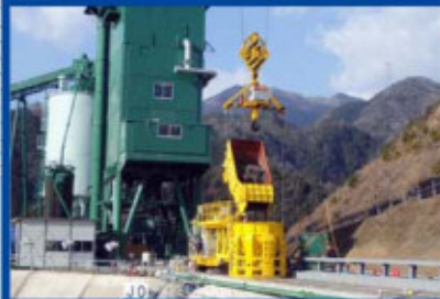
3 コンクリート運搬設備
