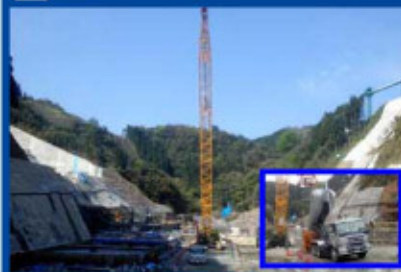
5 120t クローラクレーン
