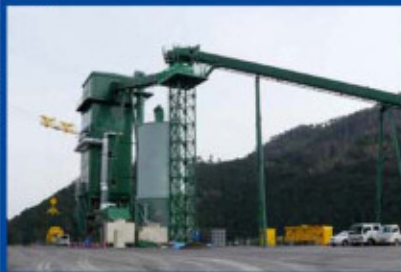
2 コンクリート製造設備
