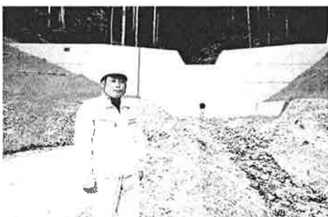
治山ダムが完成し復旧した周東町大迫
