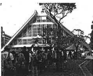
老朽化が進む下関市体育館(1963年竣工)
