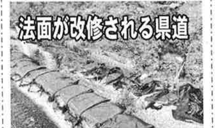
法面が改修される県道小野田美東線
