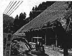
③ 四馬神復旧作業現場
