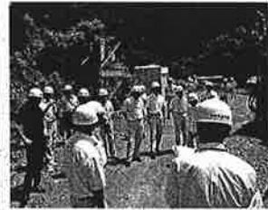
① 平瀬ダム建設工事
