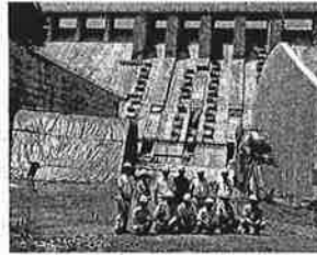
② 平瀬発電所建設事業
