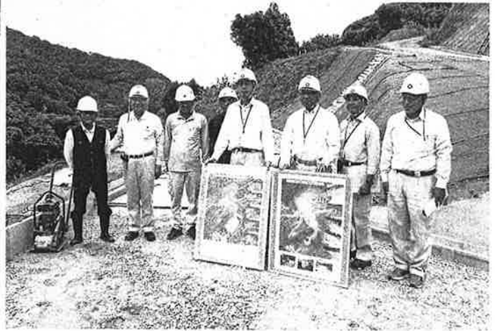
〈園地災害復旧工事〉
