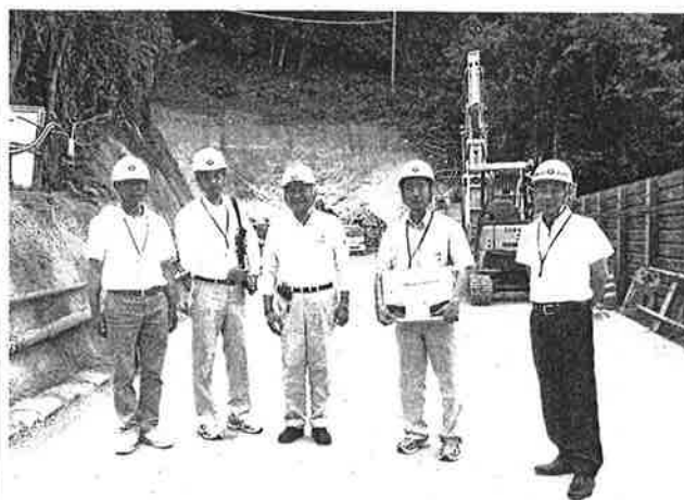
地家室トンネル工事
