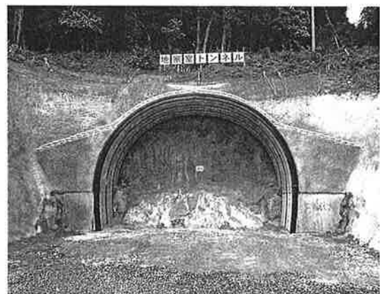
▲ 地家室トンネル工事現場
