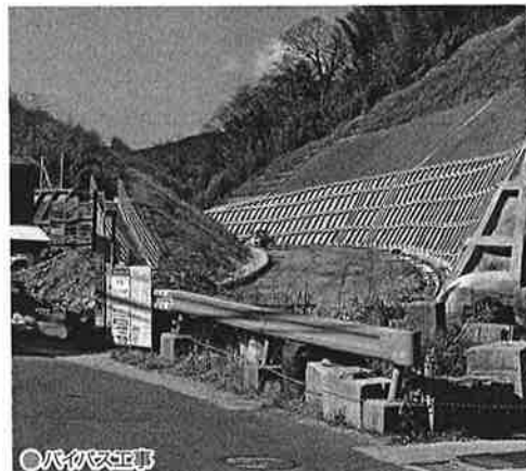
バイパス工事
