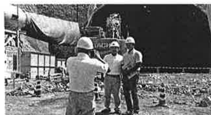
山陰道・大塚寺トンネル工事現場視察
