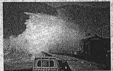
従来の護岸形式での被害状況
