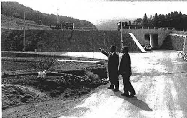
長門・俵山道路工事現場（長門市）
