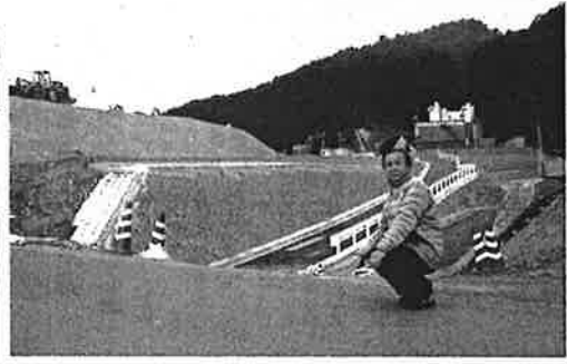
長門俵山道路現場を視察
