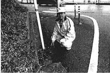
道路改修現場
