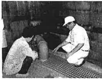
排水路のごみ除去
