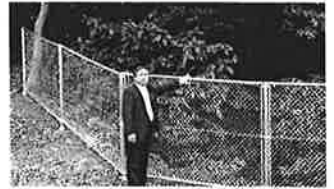
ため池のフェンス設置
