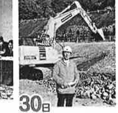
30日 国道2号富海拡幅 ICT活用工事現場 見学会
