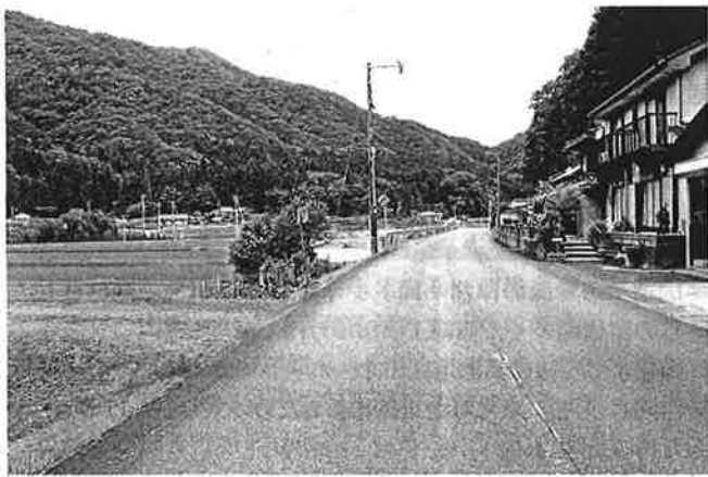
鹿野大潮桶山地区の国道315号と拡幅済道路との道路整備箇所
