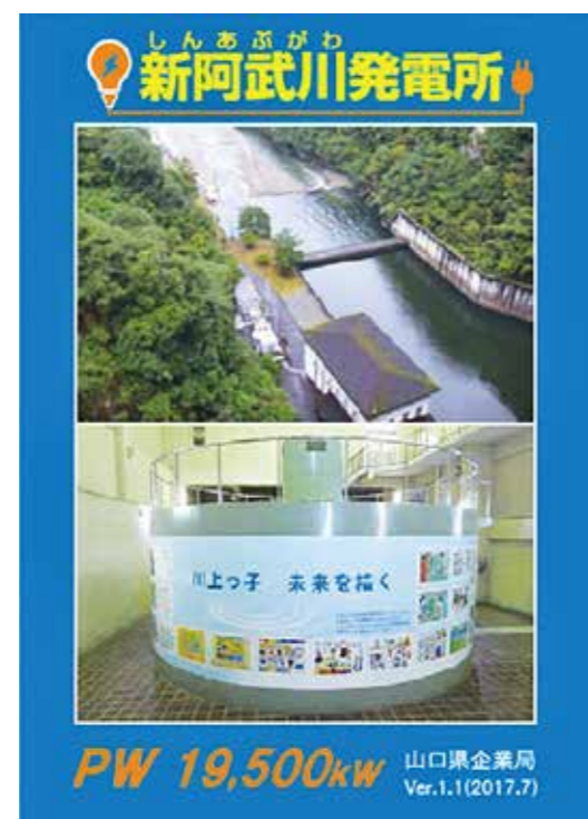
発電所カード
