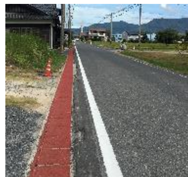
カラー舗装された路側帯
