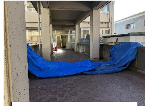
建物の倒壊、津波により通行不可
