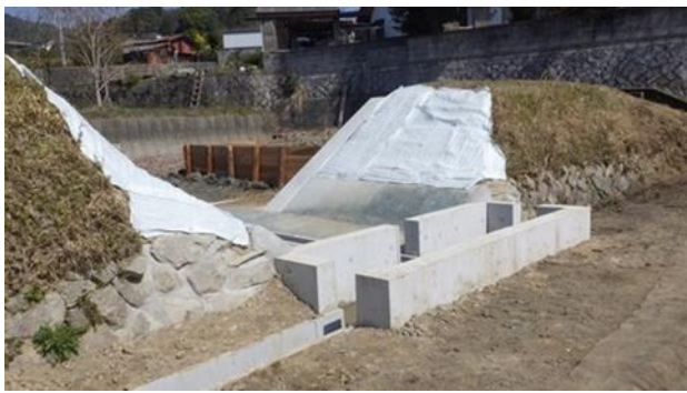
堤体を切り下げ廃止したため池 (平生町尾崎ため池)
