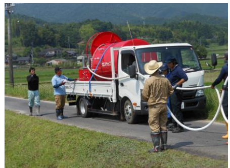
センチピートグラスの種子吹付施工研修会の様子
