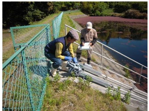
取水施設の点検状況
