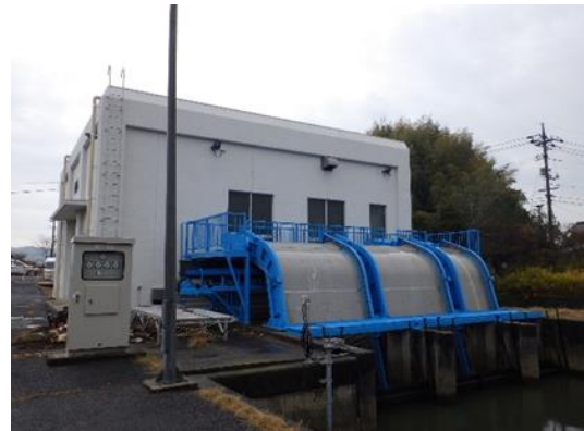
新川排水機場
