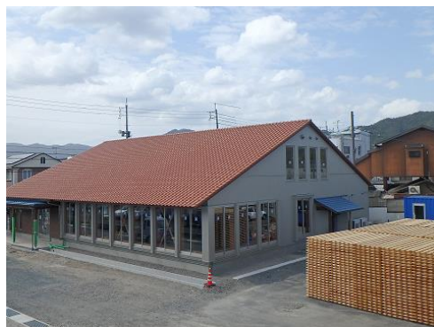
CLT を使用した新事務所
