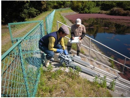
取水施設の点検状況
