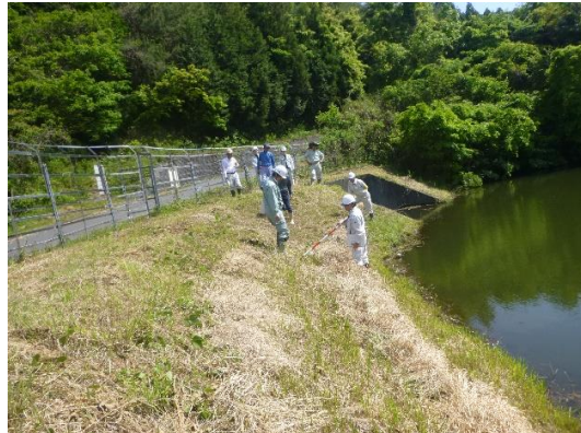
ため池点検パトロールの状況
