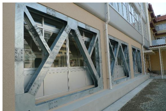
校舎耐震補強の取組
