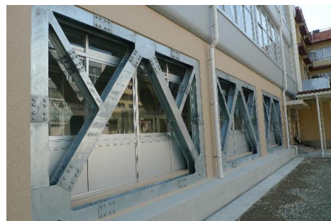
校舎耐震補強の取組
