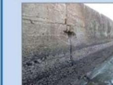
摩耗による骨材の露出
