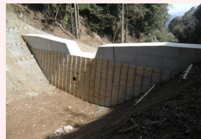
① 溪流崩壊発生前
