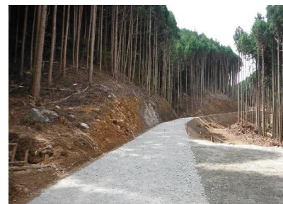
路網整備（林業専用道）
