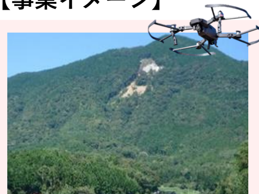
小規模な急傾斜崩壊地
