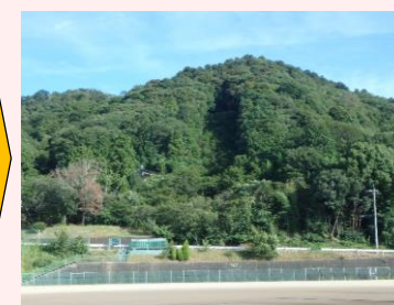
③ 施工後10年以上経過
